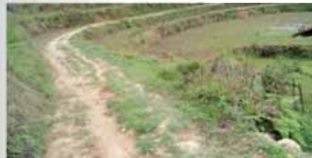
小坑村黄洞组通组公路（修路前）
