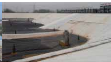
扬州杰嘉固废填埋场
