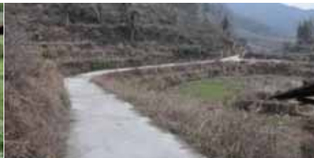
小坑村黄洞组通组公路（修路后）
